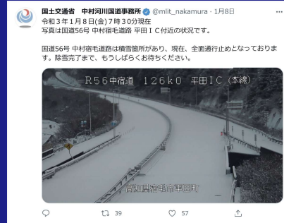
令和3年1月8日 国道56号高知県宿毛市 中村宿毛道路 平田IC付近降雪状況
